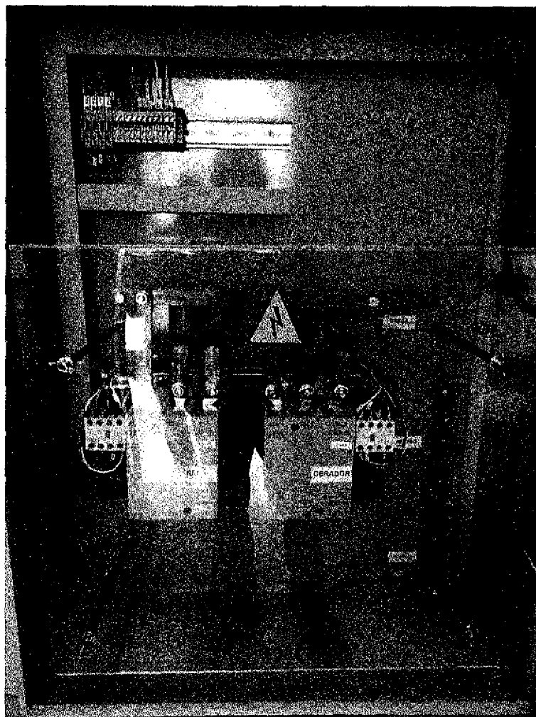
Foto 3: Painel de Alimentação Elétrica do Gerador
